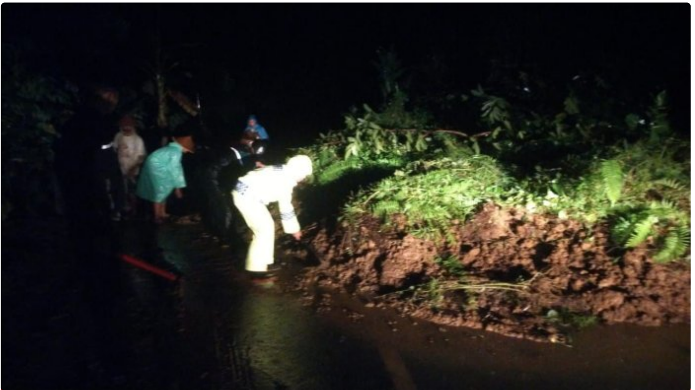
Tanah Longsor Tutup Akses Jalan di Blok Babakan Sari, Darma, Kuningan
